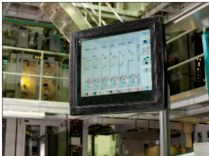
Écran d'un système de contrôle des couleurs en ligne montrant quatre zones d'encrage. La densité de l'aplat et l'engraissement du point apparaissent en haut. L'équilibre global des couleurs s'affiche dans les hexagones en bas de l'écran.
